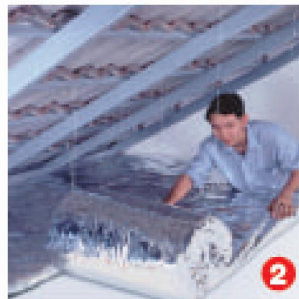
2 วิธีการปูไมโครไฟเบอร์ โดยกลิ้งตามรูปโครงสร้าง
